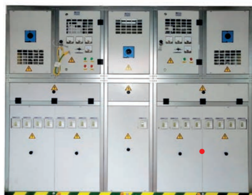
РАСПРЕДЕЛИТЕЛЬНОЕ УСТРОЙСТВО НИЗКОГО НАПРЯЖЕНИЯ ТИПА РУНН
