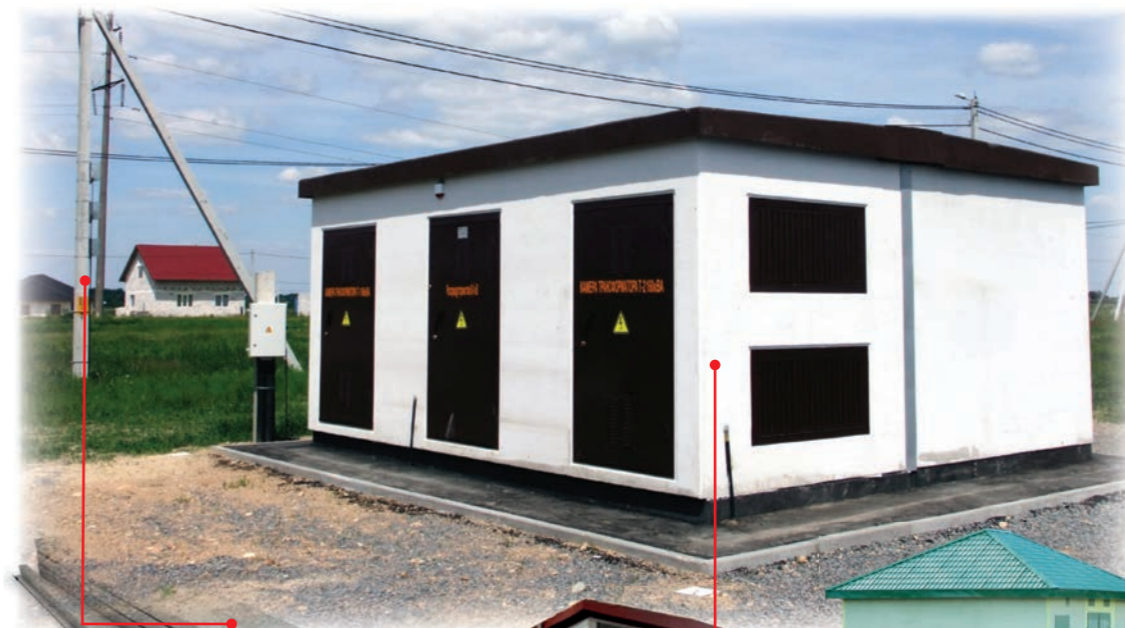
Закрытые трансформаторные подстанции с габаритными размерами от 4,8x5,0 м до 7,2x7,8 м
